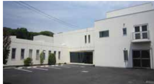
写真1 燃焼技術センター庁舎外観
