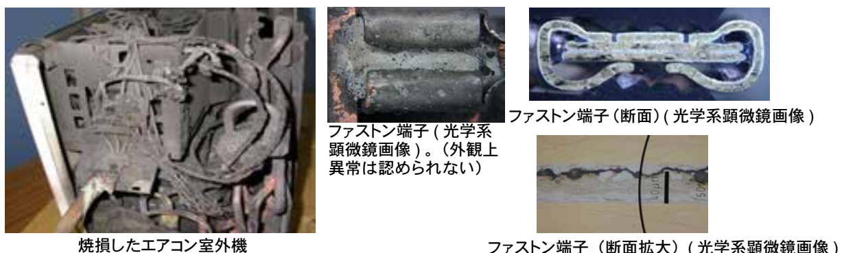
図6 製品から燃え出し、壁の一部が焼けたエアコン室外機の事故事例
